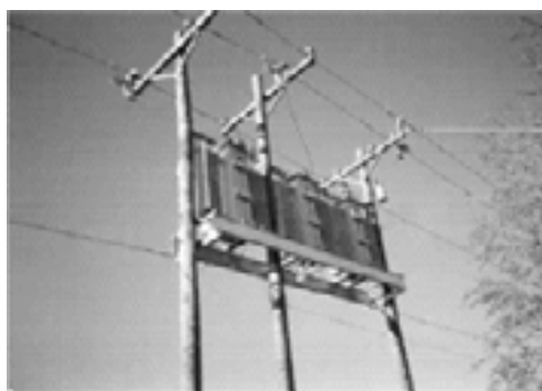
تصویر ۱۴-۱۳: تصویر SVC نصب شده در کارخانه کاغذ سازی
