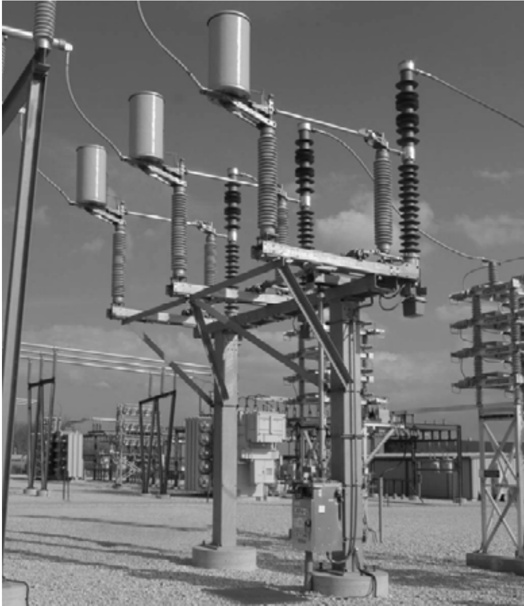
تصویر ۲۰-۲۲: سویچ مورد استفاده برای کلیدزنی بانک خازنی
