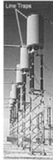
تصویر ۱۳-۲۰: خازن کوپلینگ (چپ) و لاین‌تراپ (راست)
