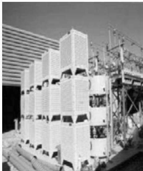
تصویر ۷-۵: بانک خازنی فشار قوی با فیلتر
