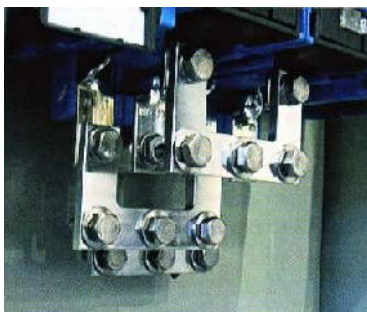
شکل ۱۷،۲- اتصالات کابل
