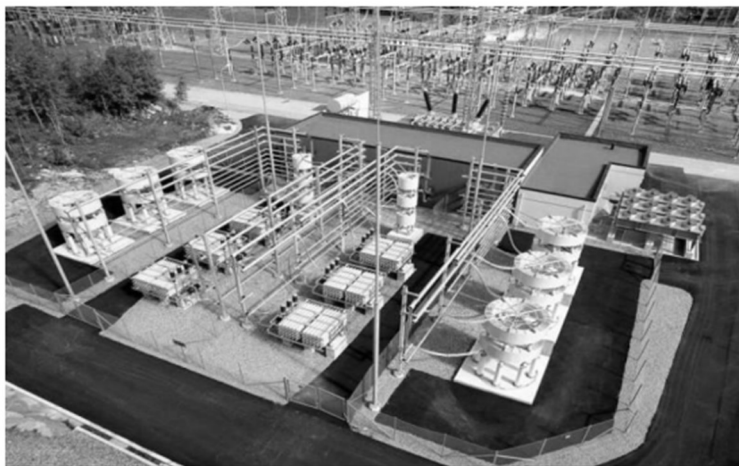
شکل ۴-۱۲: یک نمونه SVC واقعی (منبع ABB)
